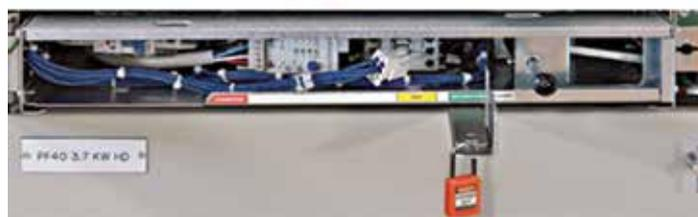
**已释放** - 抽出式单元可从柜体内卸下，从而隔离各个连接。已释放的单元可以通过抽屉杠杆锁定，从而帮助防止插入。
