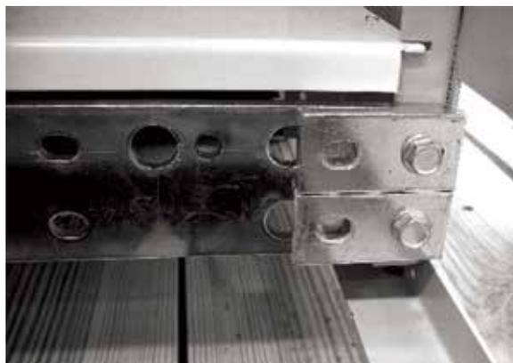
水平保护性接地 (PE) 导线
