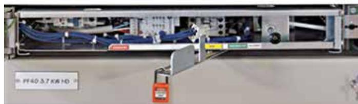
**已断开** - 隔离位置，此时单元保持封装在柜体内，PE 连接已经接合，但没有提供其它连接。可通过抽屉杠杆将单元锁定在已断开位置。
