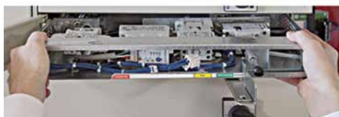
顶部到底部：抽屉杠杆位于已连接位置；抽屉杠杆位于测试位置（并上锁）；抽屉杠杆位于已断开位置（并上锁）；和抽屉杠杆位于释放位置。
