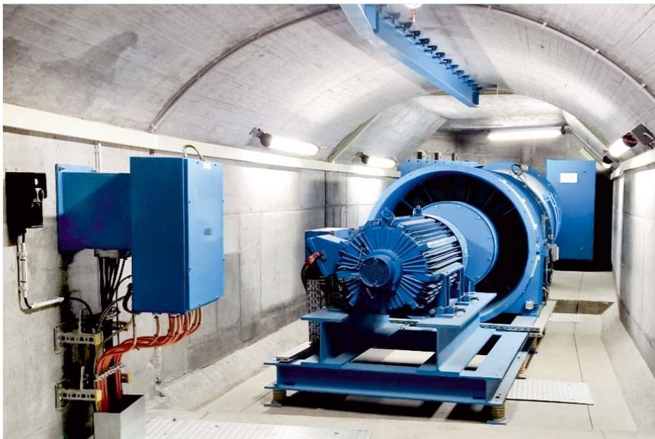
Die Tunnelbelüftung ist die leistungsstärkste der Welt. Fast sechs Jahre hat ABB an dem Großprojekt gearbeitet.
