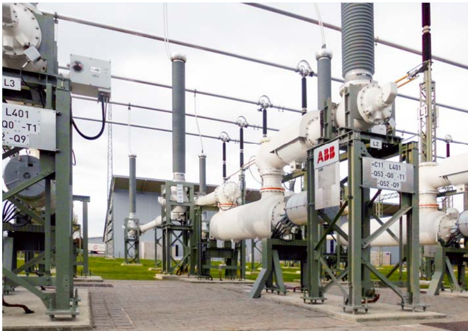
ABB baute die 220-kV-Schaltanlage mit konventioneller AIS-Technologie schrittweise und im laufenden Betrieb zu einer 420-kV-Hybridschaltanlage um.
