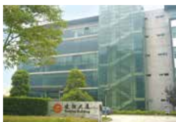
Accretech (China) Co., Ltd.
