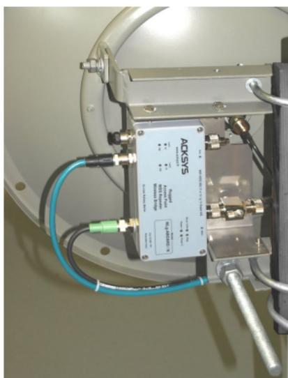
Afin d'assurer une protection maximale ainsi que pour limiter les pertes dans les câbles et connecteurs, il est fortement recommandé de connecter le parafoudre directement sur la sortie « Main » de l'Hyperlan-Pack sans utiliser de câbles supplémentaires.
