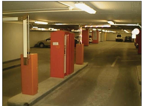
Pohled na vjezd do garáže vybavených parkovacím systémem
