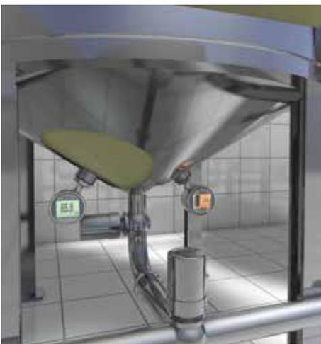
Para garantir um efeito de limpeza ideal, a temperatura do detergente no interior do tanque deve ser monitorada precisamente, visando obter uma qualidade constante do processo de limpeza e da segurança alimentar.
