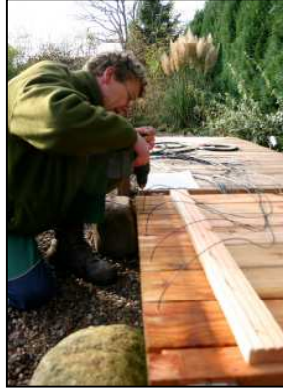
Bohren des Holzbodens mit Bohrer Ø 2.5 - 3.0 mm
