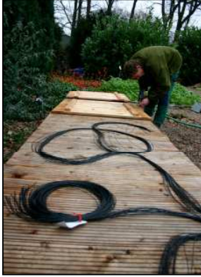
Auslegen des Lichtleitkabels
