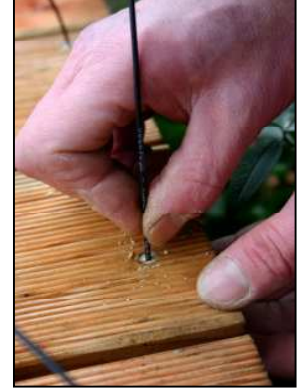
Durchstecken des Lichtleitkabels
