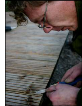
Abschneiden des Lichtleitkabels auf Holzniveau mit z.B. Cutter
