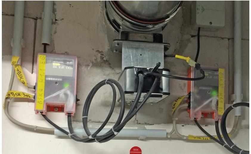
Jeder der 900 Brandschutzklappenantriebe, die in der Hochschule Hamm-Lippstadt eingebaut wurden, wird von einem BKN230-24-MOD von Belimo gesteuert und überwacht. Dadurch sind der Status und mögliche Funktionsstörungen der Brandschutzklappen permanent vor Ort am Gerät sowie auch am Monitor in der Betriebszentrale sichtbar.
