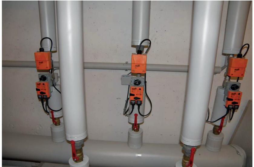
Jeder der 14 Heizkreise ist mit einem Belimo Regelkugelhahn EPIV ausgerüstet, der die korrekte Wassermenge für jede Verbrauchsstelle regelt.
