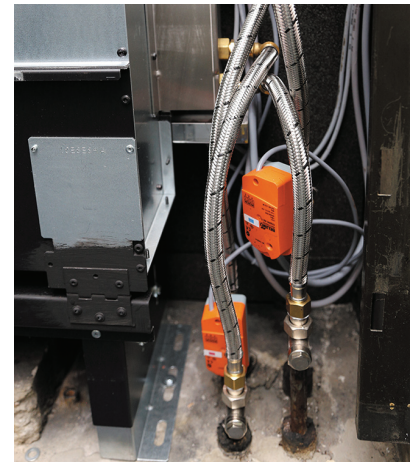
Links oben das Altgerät. Die neuen Geräte (links unten als Master) werden nun auf der Primärluftseite und auf der Wasserseite (rechts) mit Antrieben von Belimo geregelt.
