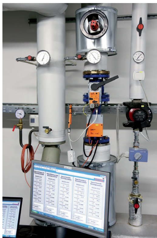
Energieventil im Monitoring-Einsatz
