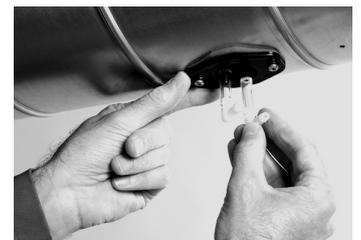
2. VAV-Regler mit Wirkdruckaufnehmer verschlauch
