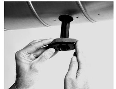
2. Wirkdruckaufnehmer mit beiliegenden Schrauben befestigen
