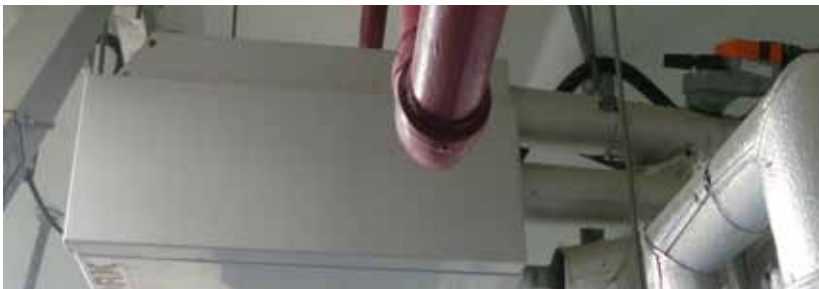
Die Gebläsekonvektoren sind mit den elektronisch druckunabhängigen Regelkugelhähnen (EPIV) von Belimo ausgestattet.
