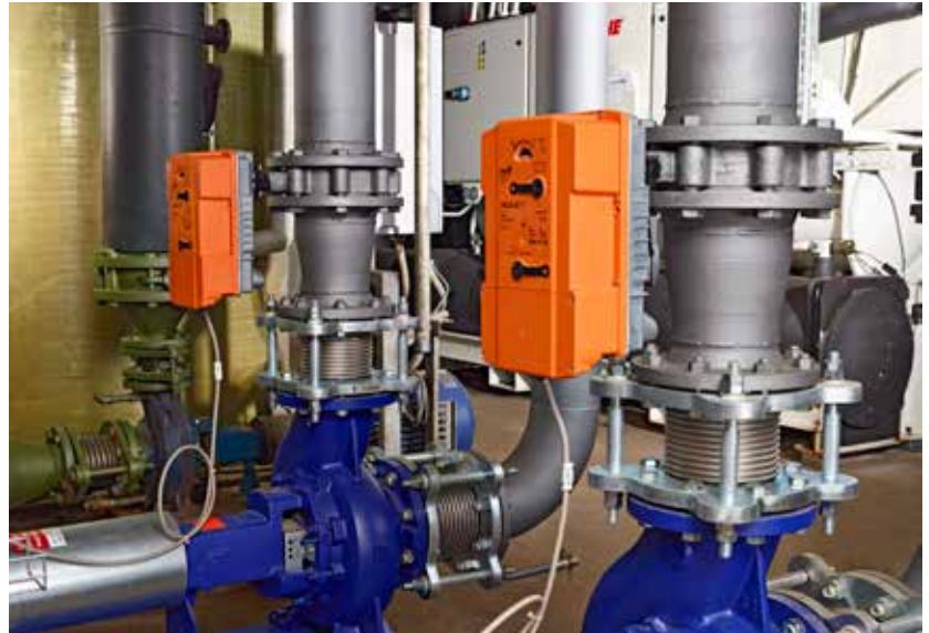
Die innovativen PR-Antriebe installiert in der neuen Anlage der Kuhn Champignon AG.
