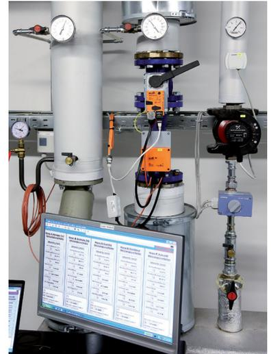
Ein Energieventil und die Statusanzeigen von fünf Energieventilen, visualisiert von der Gebäude-Leittechnik
