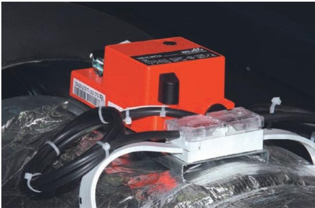
**Bild 4** Woertz-Kabelverbinder verbinden das vieradrige Flachkabel und das Rundkabel der Sensoren. Diese Verdrahtungsmethode ist sehr rationell und störungsfrei.
