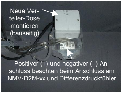
Neumontierte Anschlussdose und Diffdruckschläuche
