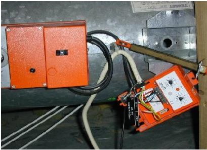
Demontage des bestehenden VAV-Regler
