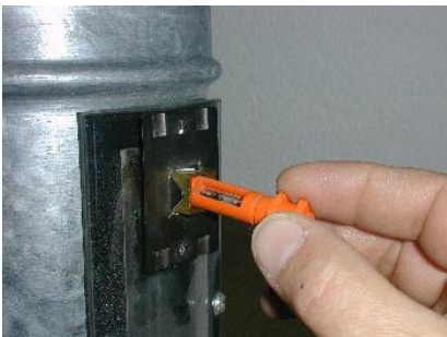
Demontage des Luftgeschwindigkeitsfühlers
