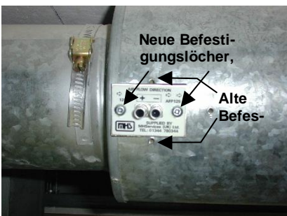
Montage des neuen Differenzdruckaufnehmer
