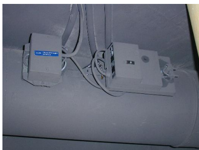
Ansicht einer bestehender VAV-Box
