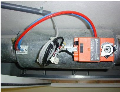
Montierter NMV-D2M-F-RE1 und Diffdruckschläuche
