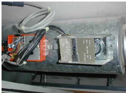
Ansicht einer bestehender VAV-Box
