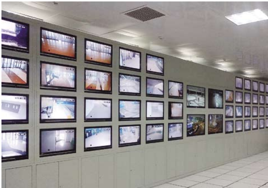
▶ 使用博世视频管理系统BVMS的机房概览
