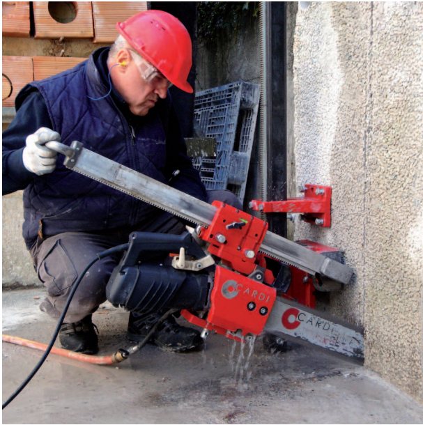
Completamento del taglio verticale fino a filo del pavimento, su parete in calcestruzzo armato.
