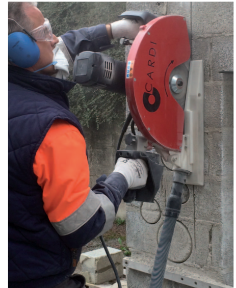
Taglio a secco di blocchi di cemento
