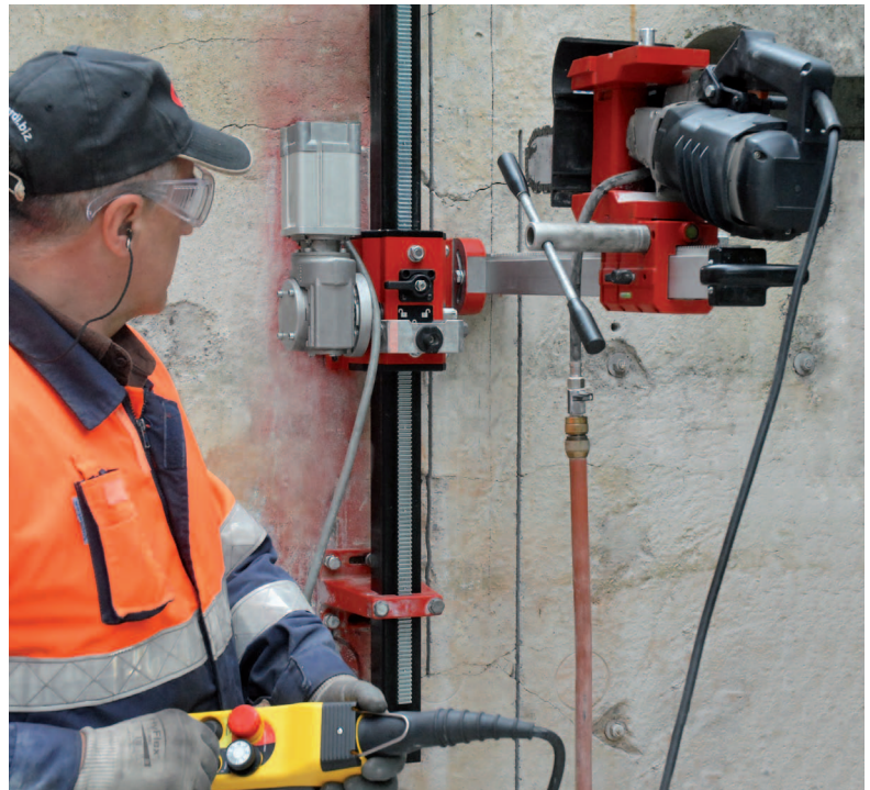
Esecuzione di un taglio con DV CD35-1500 usando il sistema semi-automatico di avanzamento DA VINCI SERVO (vedi pag.21)
