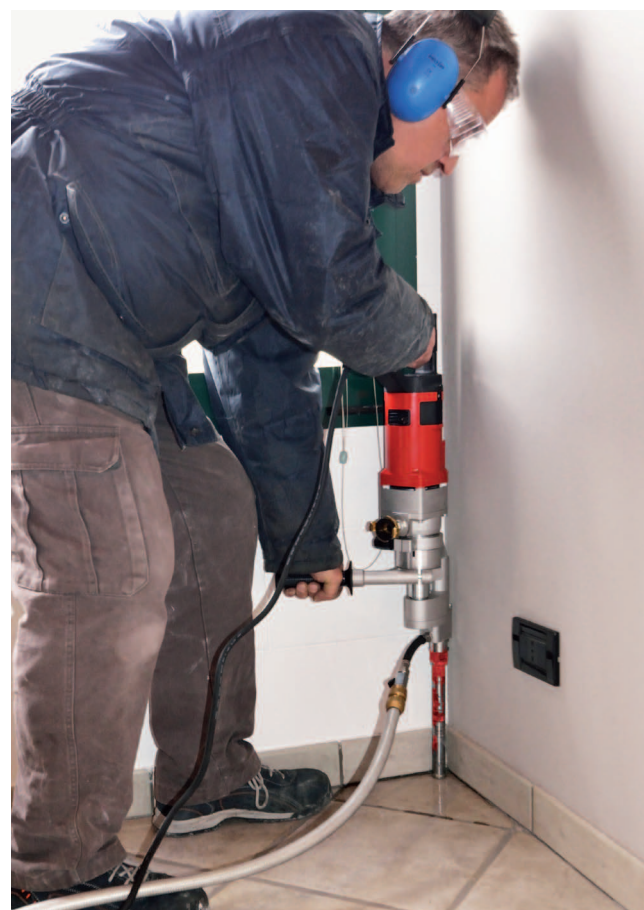
FORATURA A RASO MURO
