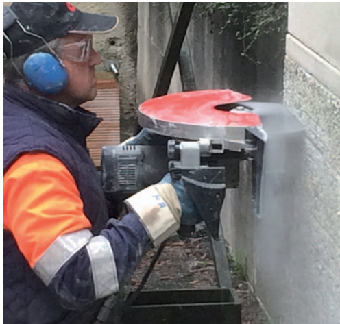
Taglio ad acqua di calcestruzzo
