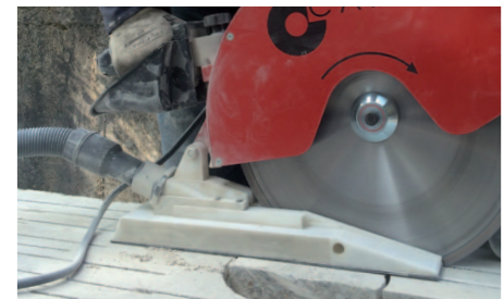
Taglio a secco di calcestruzzo
