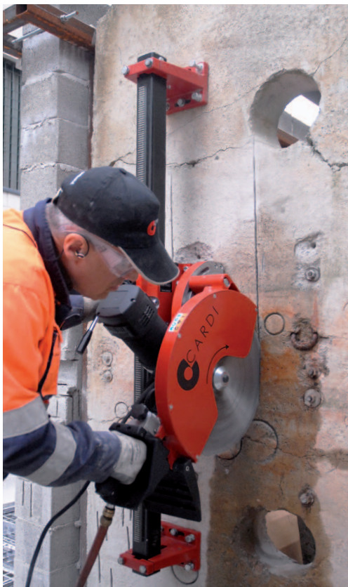
Taglio verticale per realizzazione apertura su muro di cemento
