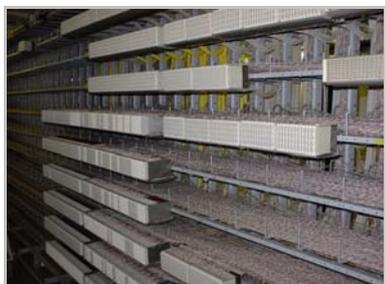
Todos los cables de abonado instalados bajo tierra se conectan a determinados componentes (caja de línea o de abonado) del distribuidor principal. Sin embargo, no todos los pares de hilos están conectados a un equipo terminal. Por ello, solamente se conectan al sistema de conmutación los hilos realmente utilizados por los abonados. Los pares de hilos que no se utilizan, se conectan al sistema sólo en caso de requerirse.
