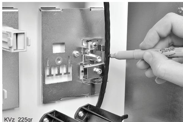
**6.4** Das Zentralelement des Kabels oberhalb der Zentralelement-Befestigung markieren und abschneiden.
