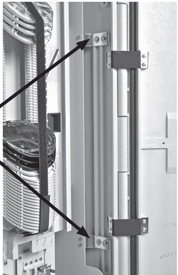
**9.2** Alle Schrauben und Klammern entfernen, um genügend Platz für die Abnahme des Gehäuses zu schaffen.
