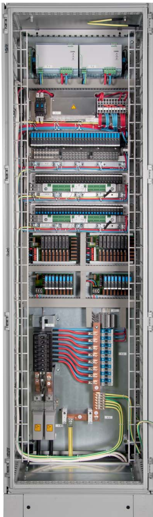
Messschaltschrank T029 (Demo)
