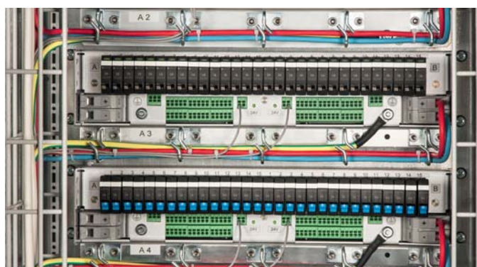
Power Distribution Module (PDM) für ESS20, 2216 und REF16
