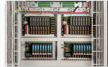
Stromverteiler mit ESS20 und ESX10-S
