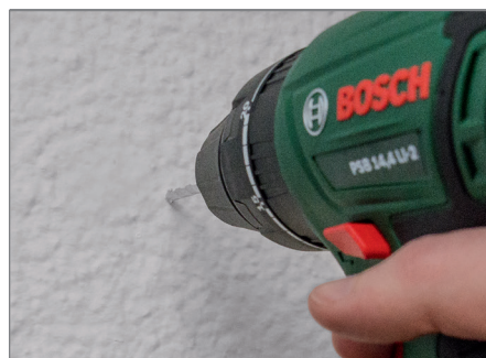
Bild 20: Zeichnen Sie die Löcher für den Wandhalter an und bohren Sie diese anschließend mit einem 5-mm-Bohrer.
