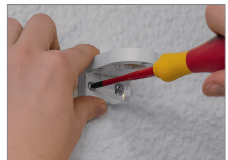
Bild 21: Setzen Sie nun die beiliegenden Dübel in die zuvor gebohrten Löcher ein und befestigen Sie den Halter mit den beiliegenden Schrauben.
