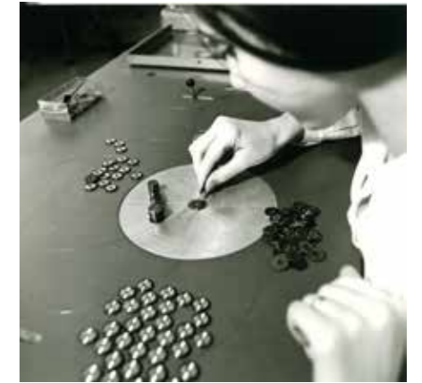
EINWINDEN VON JE 7 FEDERBÄNDERN DRAWING OUT 7 SPRING BANDS EACH
