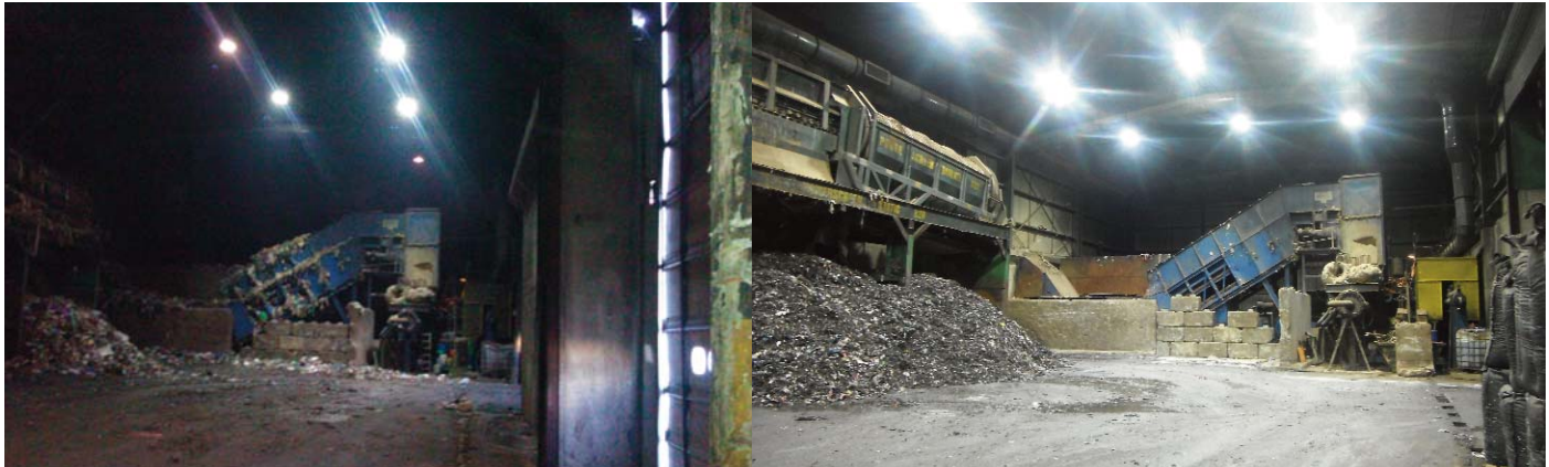
Avant et après l'installation de l'éclairage à LED
