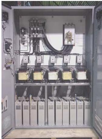
Les harmoniques générées par la charge et les thyristors sont ainsi éliminées. Les désavantages des fluctuations de la puissance réactive et les harmoniques sont donc minimisés.
