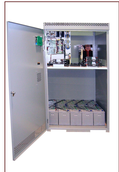
Chargeur de batterie avec batterie installée dans le même cabinet (configuration "BI")
