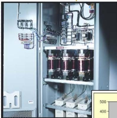
Les systèmes de transmission et de distribution d'électricité sont conçus pour fonctionner avec une tension sinusoïdale et un courant à fréquence fixe. Cependant, il existe de nombreuses charges non linéaires comme les entraînements à thyristors, les convertisseurs et les fours électriques à arc qui génèrent des harmoniques sur le réseau ce qui cause de la distorsion dans les formes d'onde de tension et de courant.
