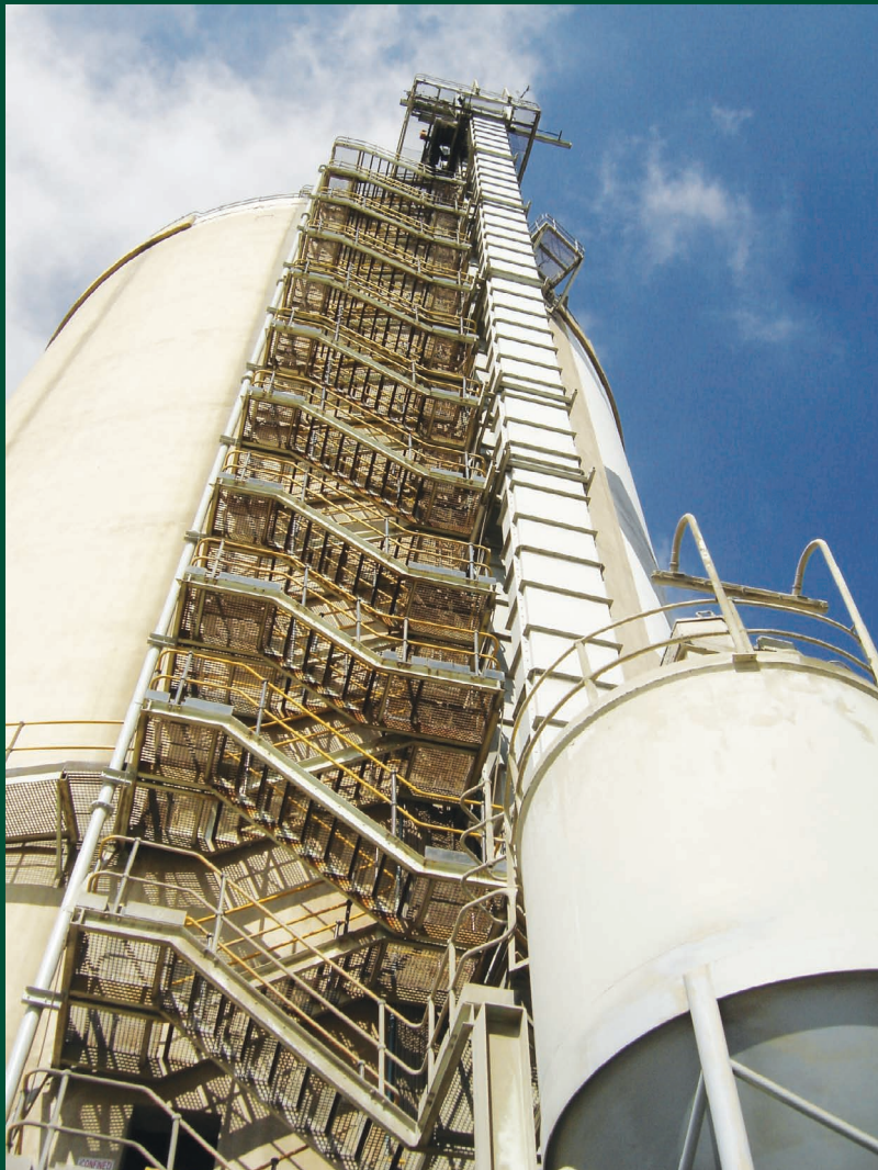
Tall Elevator in Cement Plant Elevador alto en planta de cemento
