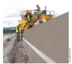
Mehrzweckfertigung einschließlich Bordkante und Rinnstein, monolithische Gehsteige, Freizeitwege, Hochbarrieren, Sicherheitsbrüstungen für Brücken und Deckenfertigung bis zu 6 m Breite und 483 mm Tiefe.
