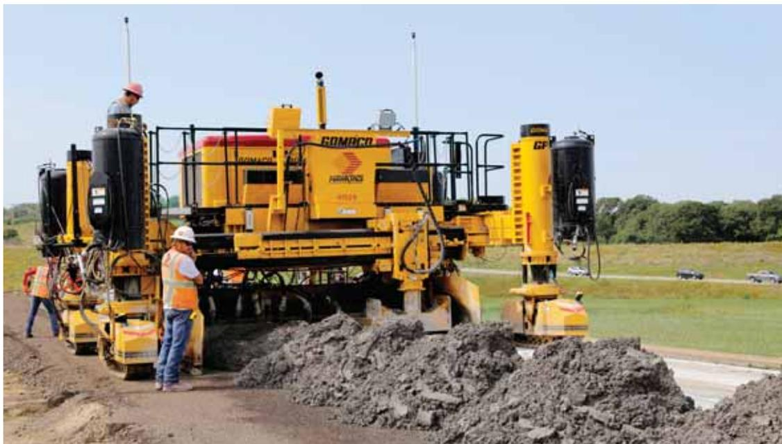
Dieser GP3 von GOMACO verfügt über einen ausfahrbaren Verteilerpflug auf der Vorderseite des Fertigers, der den Beton vor dem Schalteil verteilt.
