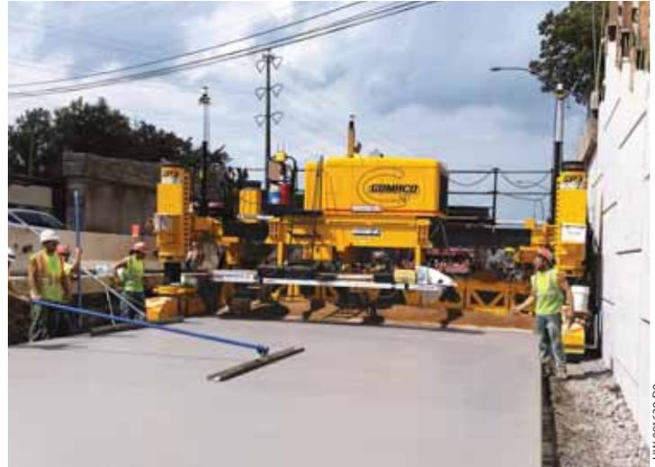
Dieser GP3 von GOMACO ist mit einem Betonierschalteil der Serie 5400 ausgestattet und fertigt einen 6,7 m breiten Abschnitt eines Autobahnprojekts. Minimalabstände werden durch das 3D-Maschinenleitsystem erleichtert.
