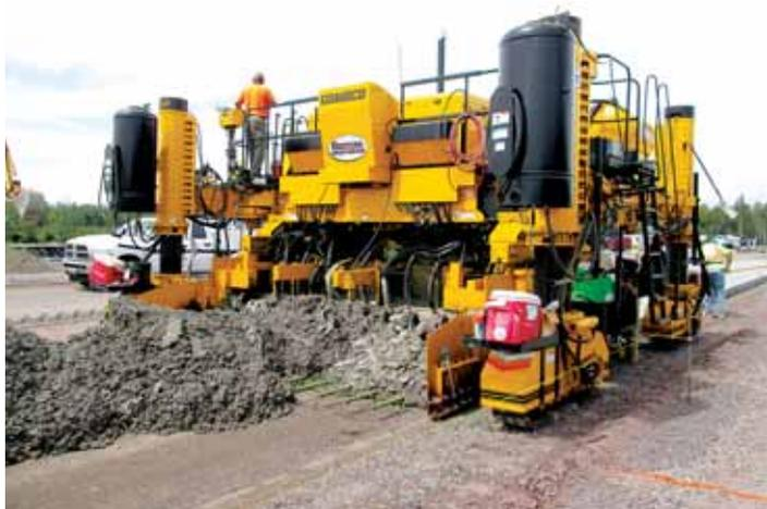
Dieser GP3 fertigt einen 4,57 m breiten und 254 mm dicken Abschnitt einer neuen Wiegestation.
