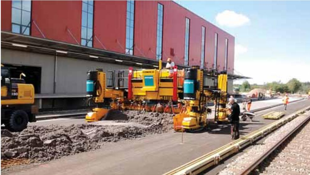
Dieser GP3 ist mit einer Schnecke bestückt, die den aufgetragenen Beton auf 5 m Breite gleichmäßig verteilt, um eine flache Betondecke zu fertigen. Der in der Schweiz im Einsatz befindliche GP3 verfügt über GOMACO-Ferndiagnostik (GRD), mittels der sich die Software aktualisieren lässt, ohne dass GOMACO-Mitarbeiter jemals das Werk in Ida Grove im US-Bundesstaat Iowa verlassen müssen.
