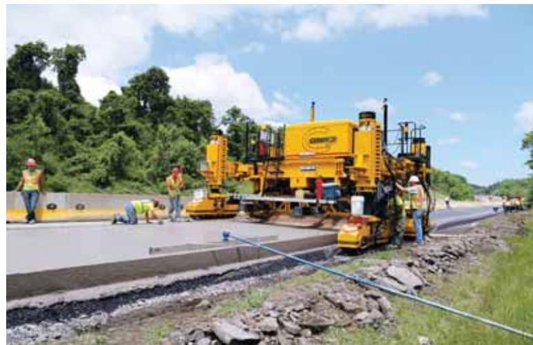
Das intelligente Breitensystem sorgt für die einfache und präzise Einrichtung von Breitenänderungen und bietet außerdem einen Bezugspunkt für das G+ zur Gewährleistung der korrekten Lenkung und Raupengeschwindigkeit bei verschiedenen Breiten des Fertigers.
