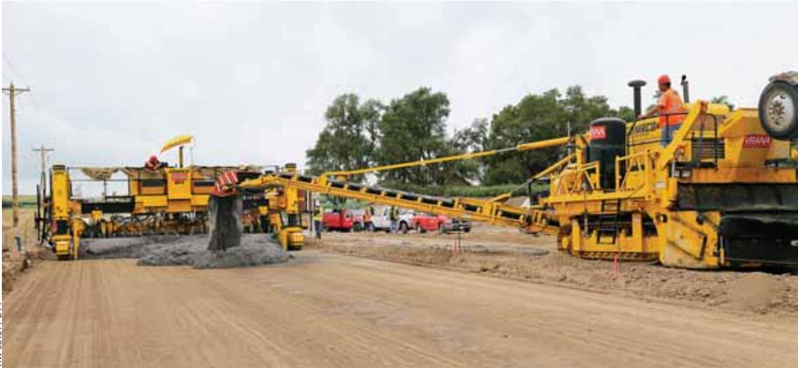
Ein GP3 von GOMACO fertigt eine 7,62 m breite Straße mit dem Beton, der von einer GOMACO-Betoniermaschine 9500 vor den Gleitschalungsfertiger aufgebracht wurde.
