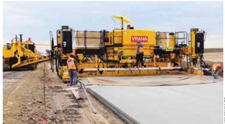
Zur leichten Bedienbarkeit erfolgt beim Ankersetzgerät der Serie 5400 das Laden der Stäbe vorne oder hinten und das Einsetzen an der Vorderseite. Das Ankersetzgerät ist am T-Träger des Schalteils montiert und ermöglicht laufende Scheitelhöhenänderungen bei Erhaltung einer gleichbleibenden Tiefe. Um einen leichten Zugang und einfaches Laden des Ankerstabmagazins zu gewährleisten, ist der Ankerstabkasten an der hinteren T-Trägerbefestigungsschiene des Fertigers montiert.
