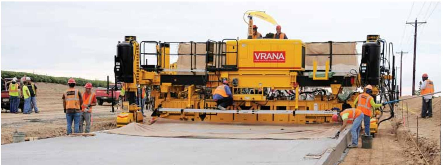
Der GOMACO GP3 ist mit G+ Bedienungselementen ausgestattet und fertigt eine 7,62 m breite Straße mit einem integrierten Bordstein auf der einen Seite. Außerdem verfügt der GP3 über ein Schalteil der Serie 5400, ein Ankerersatzgerät der Serie 5400 und ausfahrbare Endabschnitte für Breitenänderungen.
