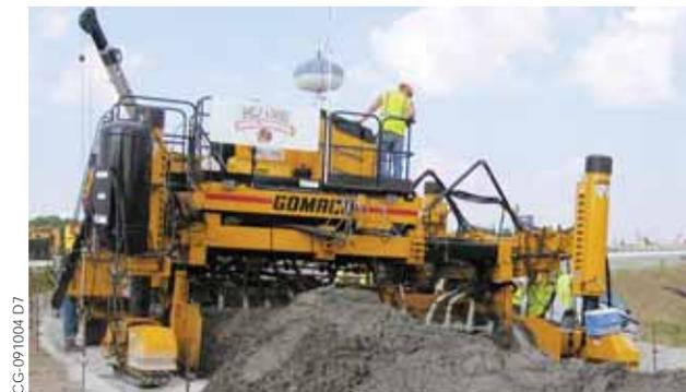
La Commander III de cuatro orugas con accesorio IDBI puede pavimentar anchos de hasta 4,9 metros.
