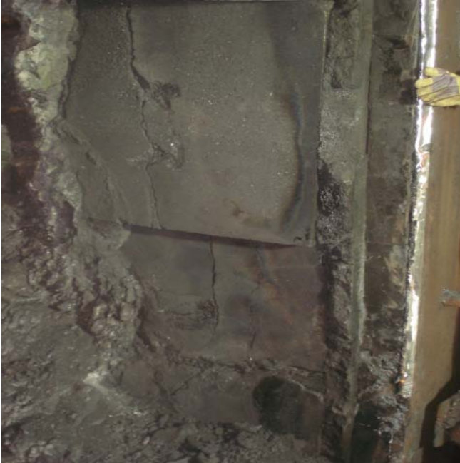
图 2. 微孔炭块炉缸的典型侵蚀和开裂，也称“环裂”。本图是经过 8 年炉役的炉缸情况。
