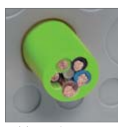
Widok z przodu przepustu.
