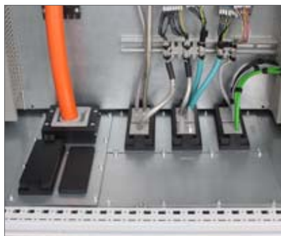
Wprowadzanie kabli przez płyty modułowe w podstawie szafy Rittal TS8. Montaż przy zastosowaniu płyt KDR-BMP.
