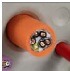
Widok z przodu przepustu.
