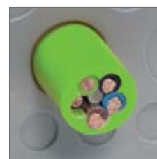
Widok z przodu przepustu.
