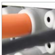
Widok z tyłu przepustu.
