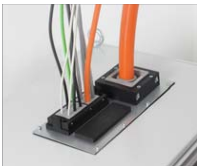
Zavádění kabelů různých průměrů do uzavřeného stropu rozváděče, pomocí vymezovacího plechu. Rozměr výřezu 314 x 144 mm.
