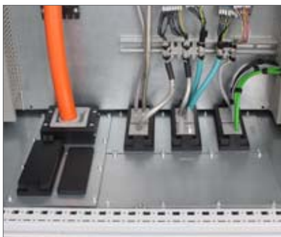
Zavádění kabelů do rozváděče Rittal TS8 pomocí vymezovacích plechů, umístěných v plechu KDR-BMP
