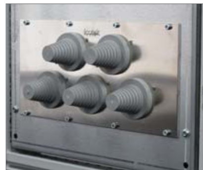
Zavádění kabelů do oddělovací stěny rozváděče Rittal TS8 pomocí vymezovacího plechu
