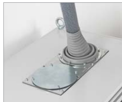
Zavádění neohebného napájecího kabelu do uzavřeného stropu rozváděče, pomocí vymezovacího plechu. Rozměr výřezu 314 x 144 mm.
