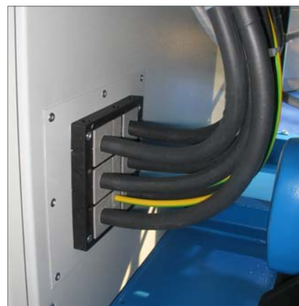
KEL 24|12-2MT - Стр. 18 Прокладка 6 больших кабелей до 34 мм в одной раме и одном проеме.
