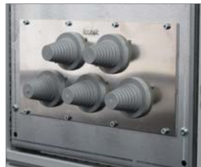
Passaggio di cavi attraverso un paratia di un quadro Rittal TS8 con piastre modulari.
