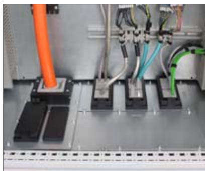
Passaggio di cavi con piastre modulari sul fondo di un quadro Rittal TS 8. Installazione con piastre per fondo quadro icotek KDR BMP.
