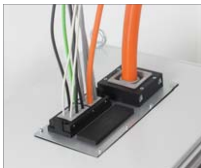
Passaggio di parecchi cavi intestati e non attraverso un quadro chiuso con piastre modulari. Dimensioni dell'apertura 314 x 144 mm.
