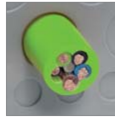
Vue détaillée de face, 1er joint d'étanchéité.
