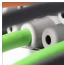
Vue détaillée de dos, 2ème joint.
