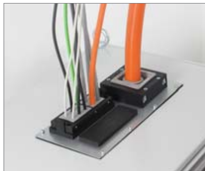
Introduction de câbles d'alimentation rigide avec une plaque modulaire sur le toit d'une armoire. Dimension de la découpe 314 x 144mm.
