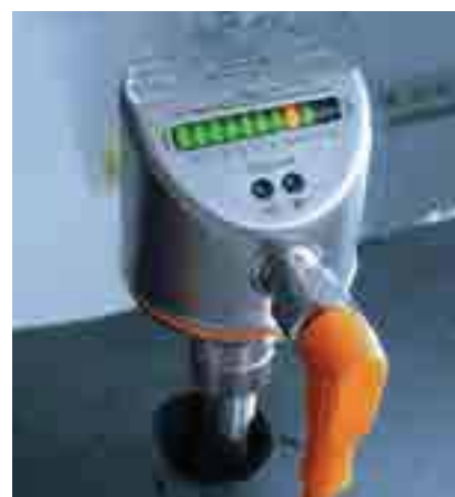
Kontrola nejmenších průtokových množství: Senzor proudění v kombinaci s adaptérem proudění.
