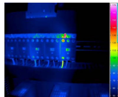
Abb. 2: Leistungsschalter – defekter Anschluss
