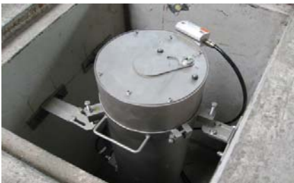
IR-Kamera 2 im Schutzgehäuse zur Messung nach dem Pressen
