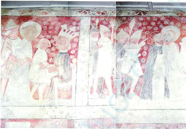
Abb. 20: Wilschdorf, Lichtbild mit Schadenskartierung im Messbereich C
