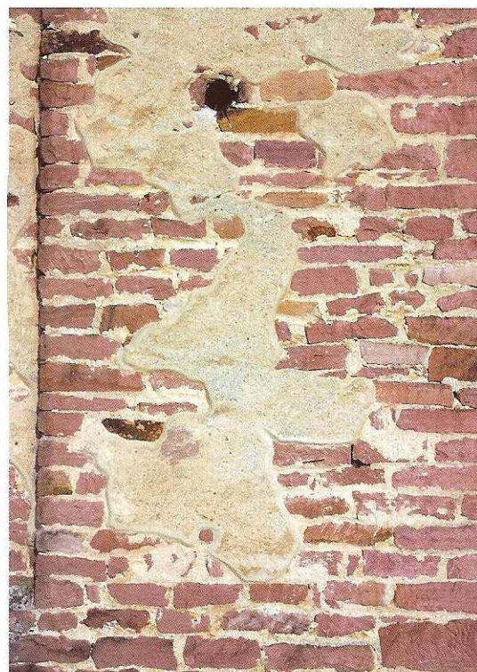
Abb. 16: (links) Bad Dürkheim, Klostersruine Limburg, Romanische Putzfläche (2005)
