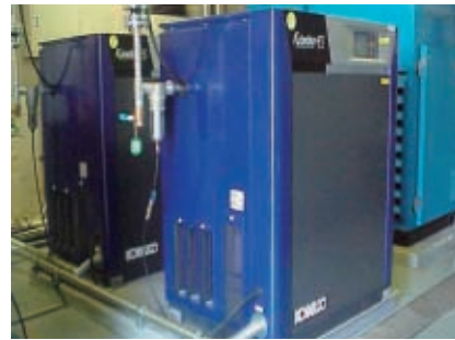
コンプレッサー
