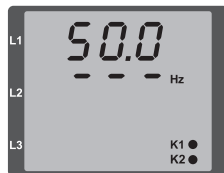
Afb. er kan geen draaiveldrichting worden vastgesteld.
