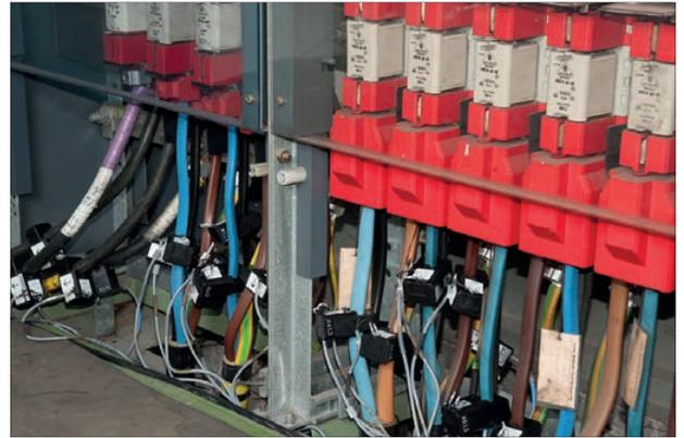
*Bild 7 (links): Die Wandler sind sowohl an den Abgängen als auch an den Zuleitungen vom Trafo installiert. So erhält man ein vollständiges Bild der gesamten Situation.*
