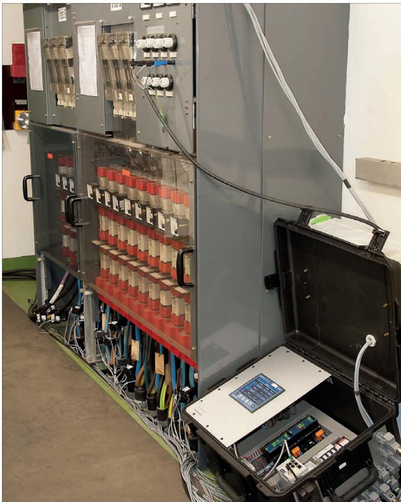
*Bild 9: Die mobile Messbox neben einem Abgangsfeld. Die Klappwandler lassen sich ohne Eingriff am Leiteranschluss montieren und demontieren. Das macht den mobilen Einsatz erst möglich.*
