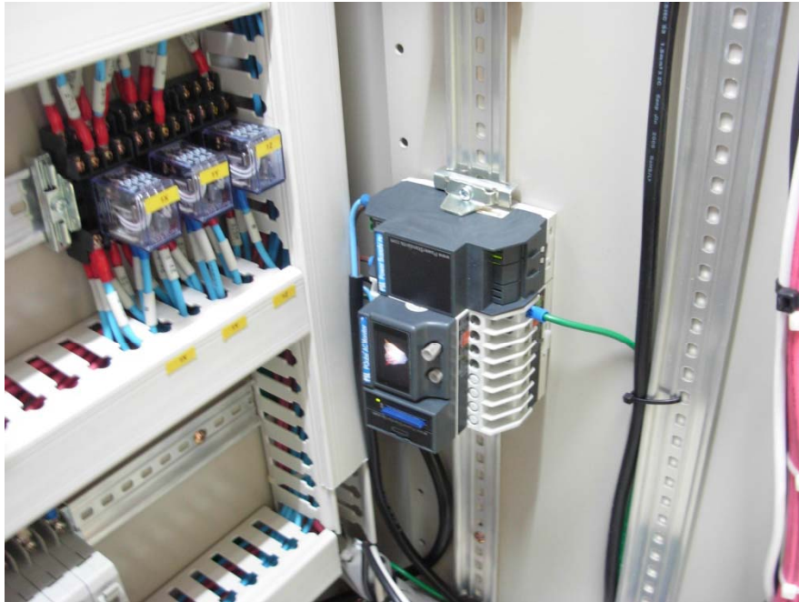
154KV ○○변전소 전압, 주파수 감시용 PQube 설치 사진
