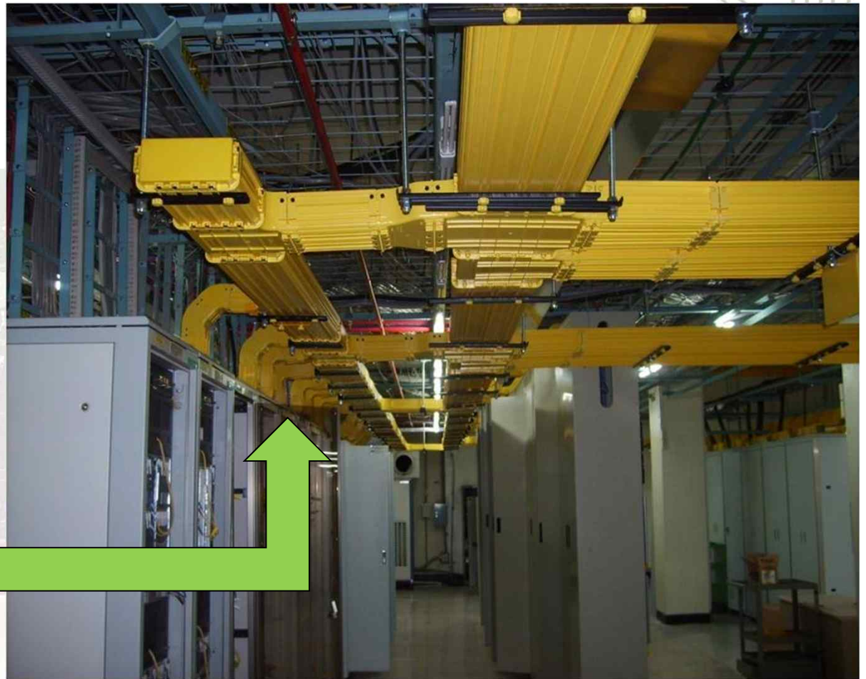
광 덕트 시스템 방식 (상단처리 방식)
