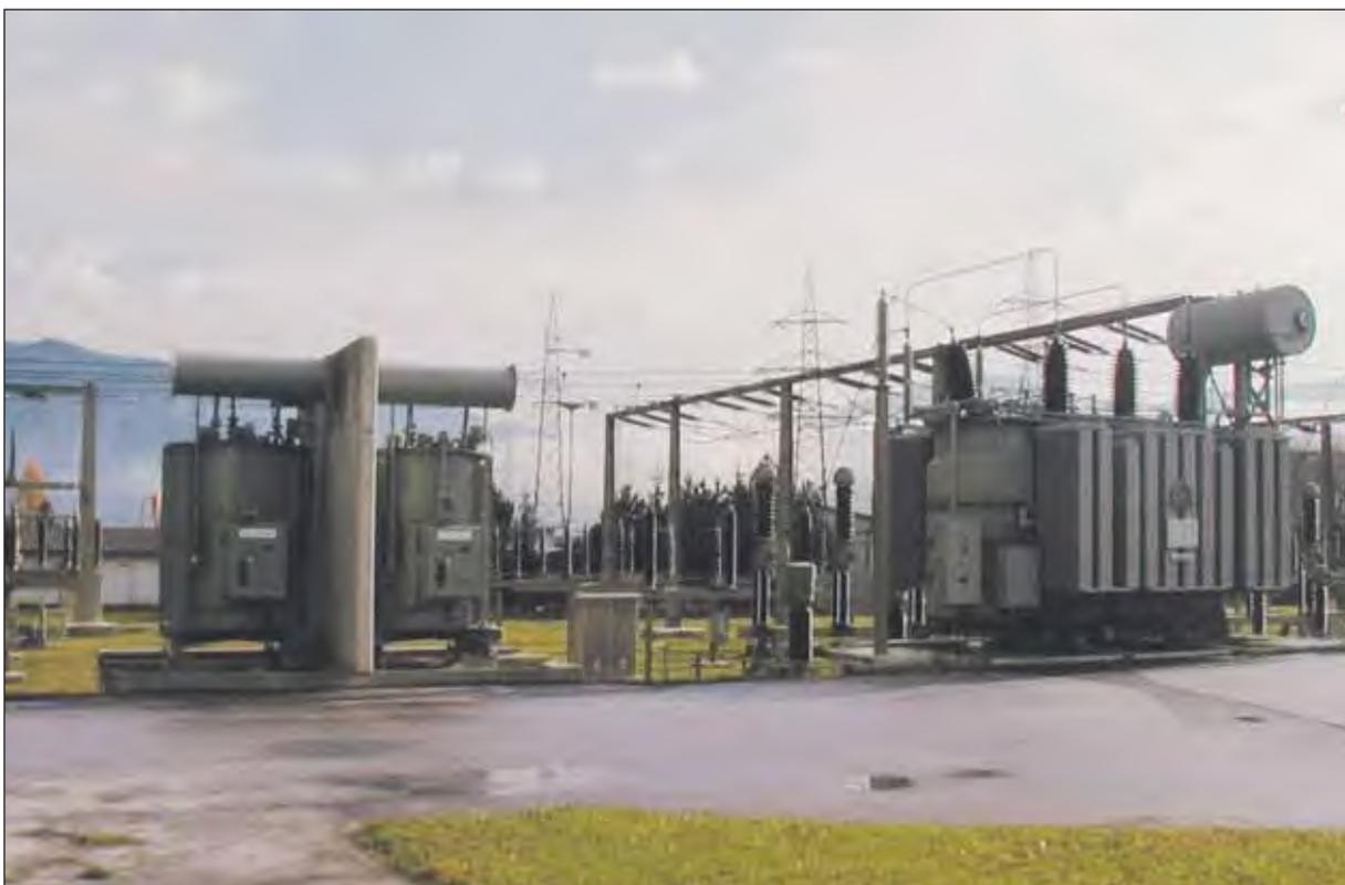
Abb. 1 110 / 20 kV Freiluftanlage mit Erdschlusslöschspulen
